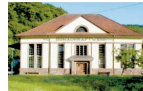
produktion von 5,3 GWh leistet das Kraftwerk mehr als alle anderen elf Anlagen im Landkreis Tuttlingen zusammen. Dies liegt neben dem günstigen Wasserdargebot aus Donau und Bära insbesondere an der eindrucksvollen Fallhöhe von 16,2 Metern. Dies wird bei der Begehung der tief liegenden Maschinenhalle ersichtlich.
